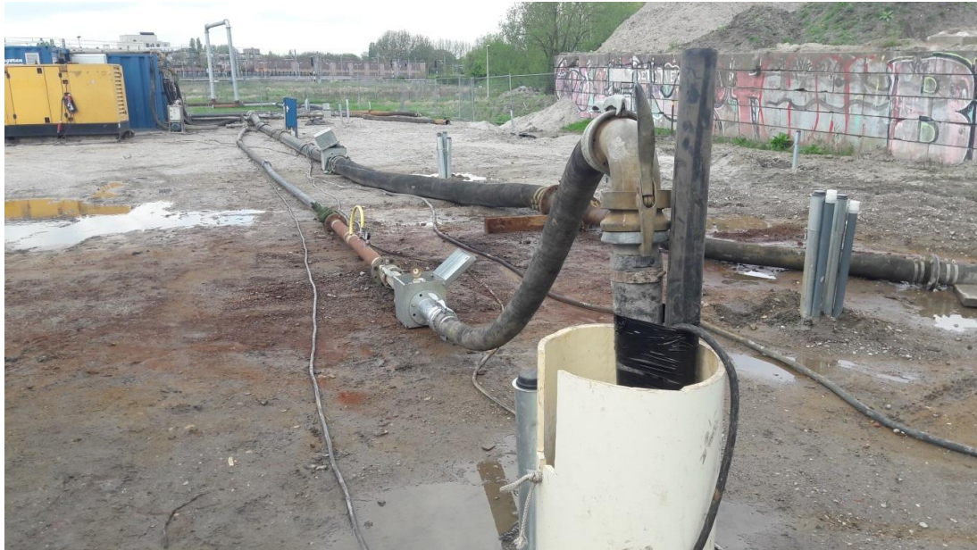
Figuur 12.1 Pompput 1 met afvoerleiding waarin watermeter en monsterpunten in de richting van waterzuivering en pijpenbrug. Tevens is de westelijke meetraai met peilbuizen in stalen kokers te zien.
