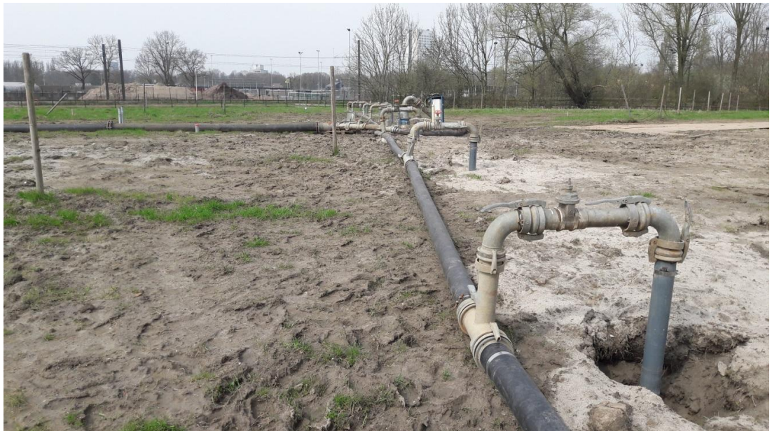
Figuur 12.12 DSI-streng 2 na aanleg
