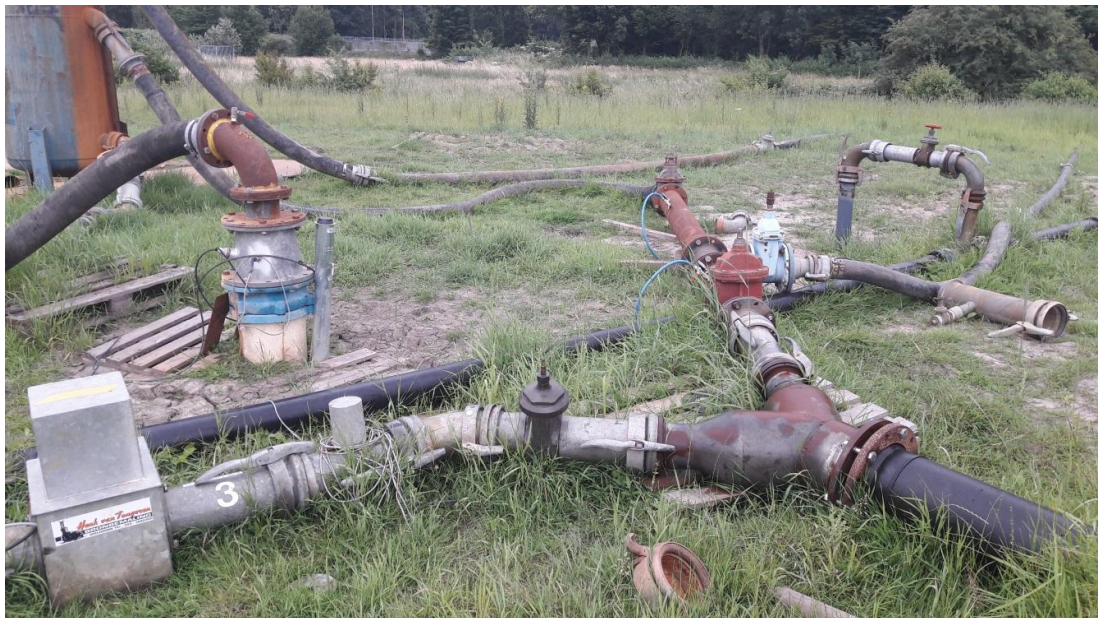
Figuur 12.9 Verdeelstukken RP3 en DSI-streng 2 met afsluiters, watermeter en monsternamepunten
